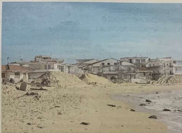
Litorale. Gli interventi di ripascimento della spiaggia a Casuzze
