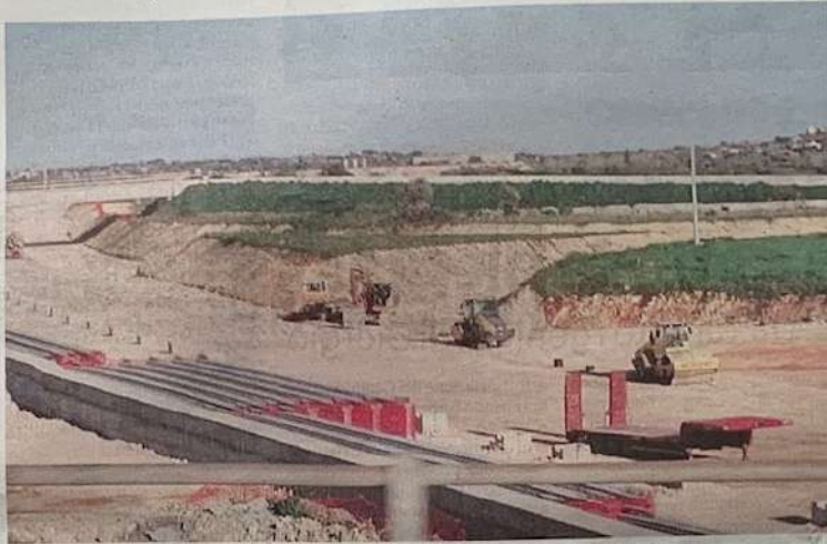
Infrastrutture. Il troncone viario con caratteristiche autostradali in via di realizzazione
