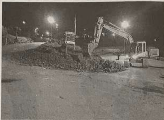
L'AVVIO DEI LAVORI IN NOTTURNA LUNGO IL CURVONE
