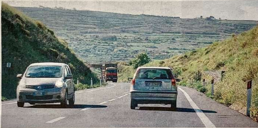
Viabilità. Un tratto della Ragusa-Catania, il raddoppio della strada è considerato vitale dai sindacati
