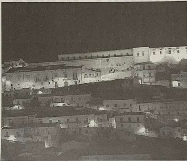
LA LUCE CALDA È STATA ELIMINATA IN ALCUNE PARTI DEL CENTRO STORICO CITTADINO
