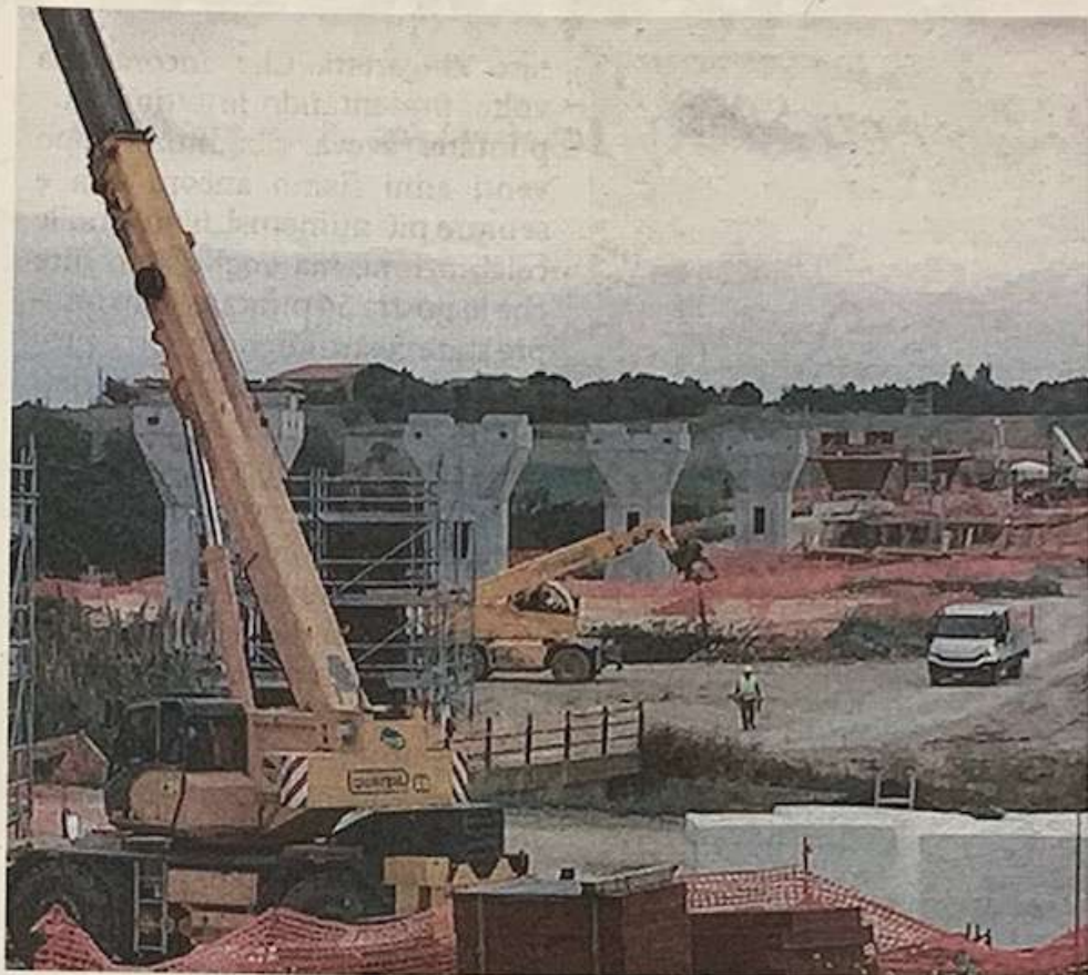
Autostrada. Uno dei cantieri nel tratto tra Rosolini e Ispica
