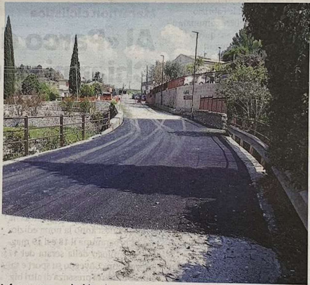
Infrastrutture a rischio. I lavori di messa in sicurezza realizzati in due mesi
