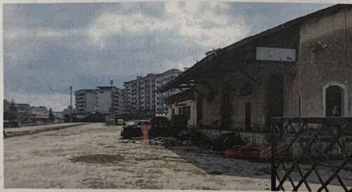
Immobili. Lo scalo vecchio delle Ferrovie
