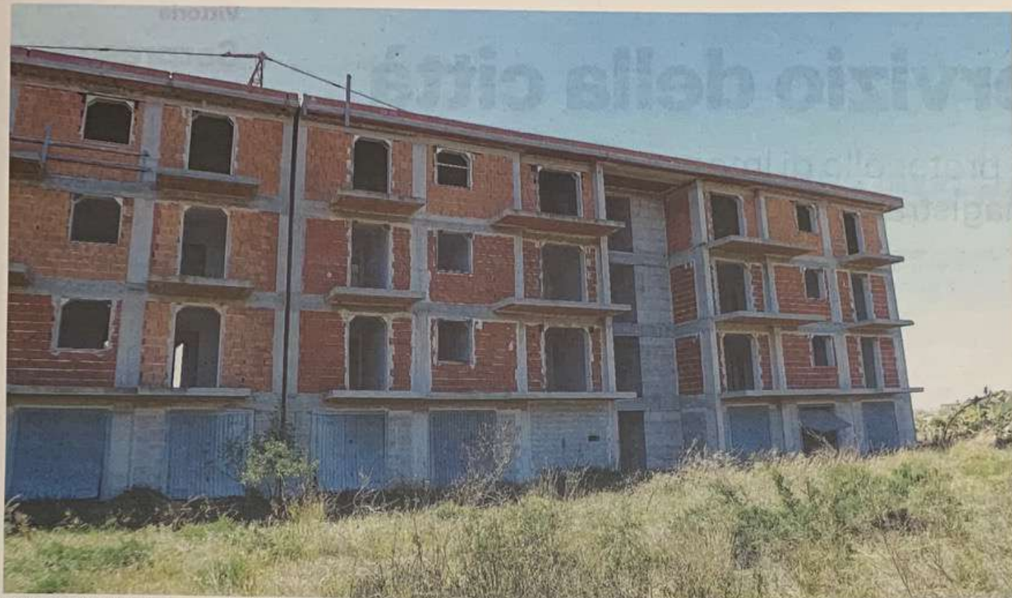
L'incompiuta. Gli alloggi popolari di Costa degli Archi (*FOTO MDG*)
