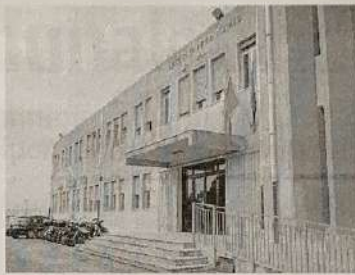
La sede del liceo Galileo Galilei dove sarà ristrutturata la palestra grazie ai fondi provenienti dal ministero
