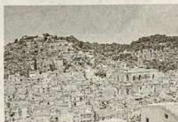
Tre monumenti cittadini potranno beneficiare dello stanziamento di 2,4 milioni di euro proveniente dalla Regione
