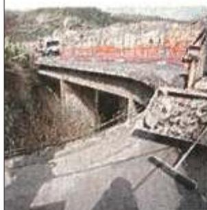
e sta procedendo con il ripristino del cordolo in cemento armato. La nuova barriera sarà realizzata con strutture in acciaio corten a doppia barra in legno lamellare. "Stiamo intervenendo con celerità per realizzare un'opera finalizzata alla sicurezza stradale ed a migliorare il decoro urbano - spiega il
