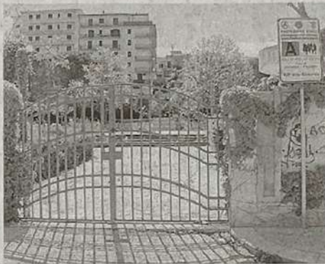
IL CANCELLO NELLA VILLETTA DI VIA SILLA
