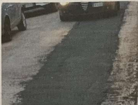
LA VIA GARIBALDI OGGETTO DELLA CONTESTAZIONE
