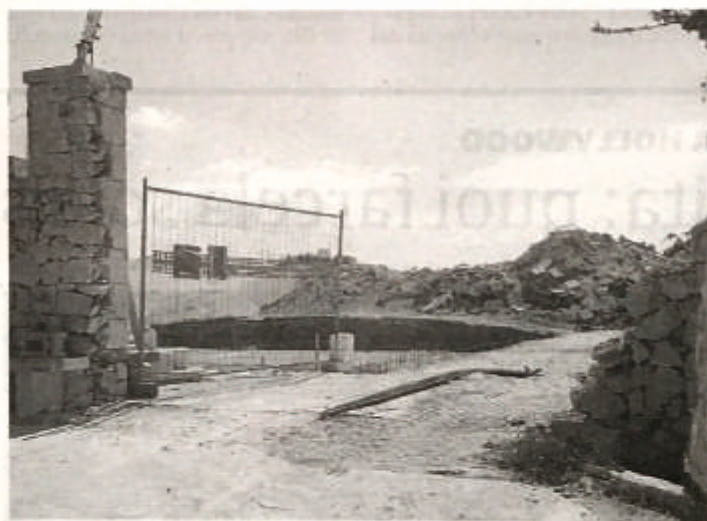
Il cantiere tra le dune di Marina di Modica. Si fa sempre più aspro il dibattito sulla nascita di una nuova struttura turistica proprio in questa zona
