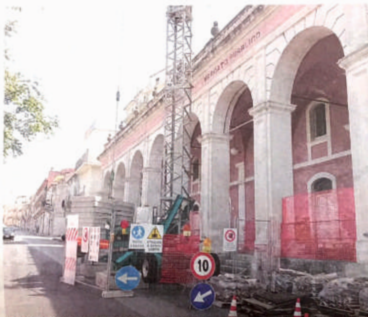
LA ZONA DI VIA DEL MERCATO IN CUI HANNO PRESO IL VIA I LAVORI DA QUALCHE GIORNO
