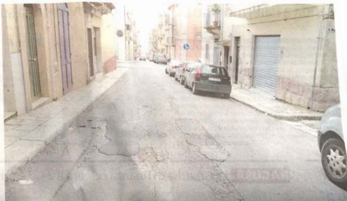
Via Sant'Anna e dintorni saranno soggette ai lavori per il rifacimento della rete idrica
