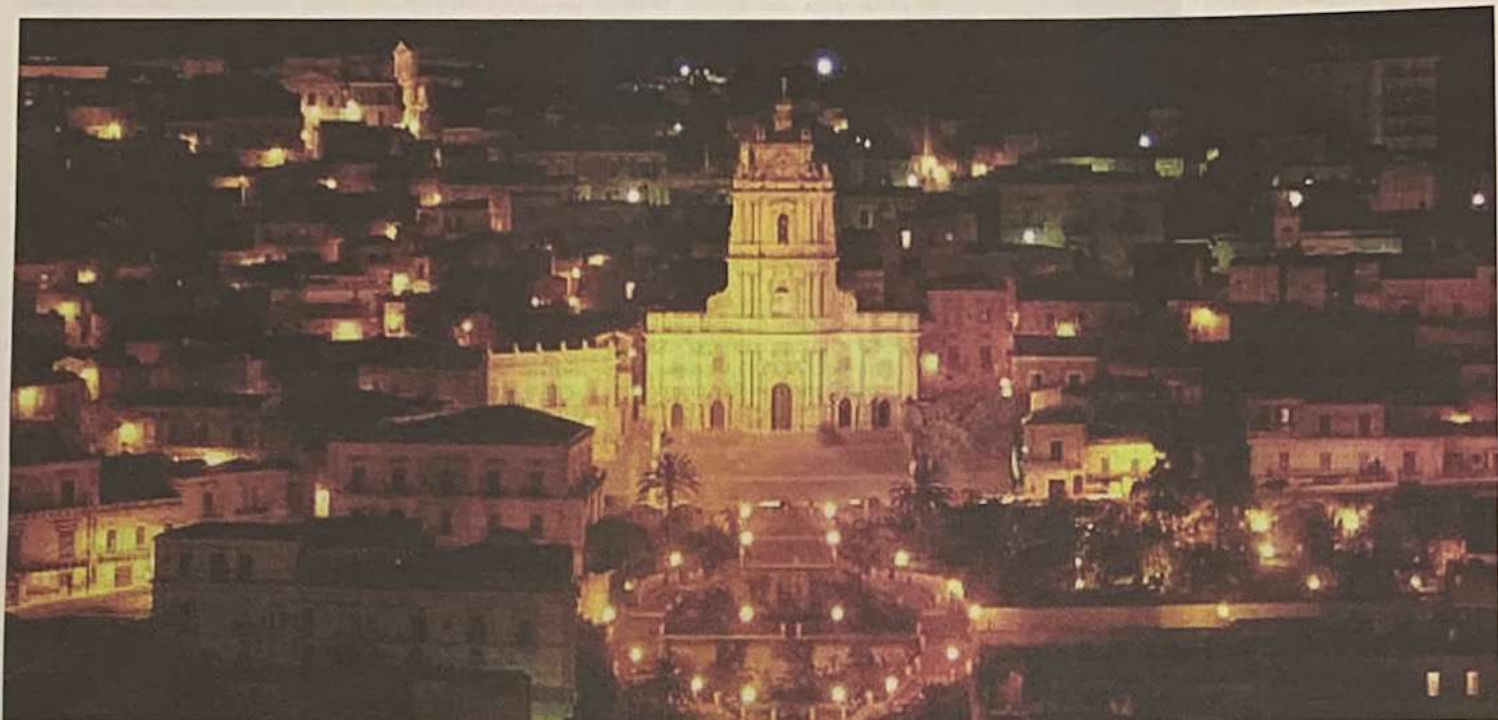
La città della Contea vista di notte. La vecchia illuminazione del sito patrimonio Unesco
