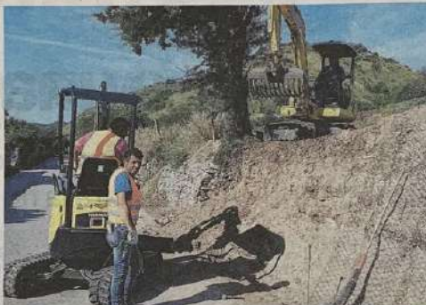
Cantieri. Una squadra alle prese con la perimetrazione dei muri a rischio
