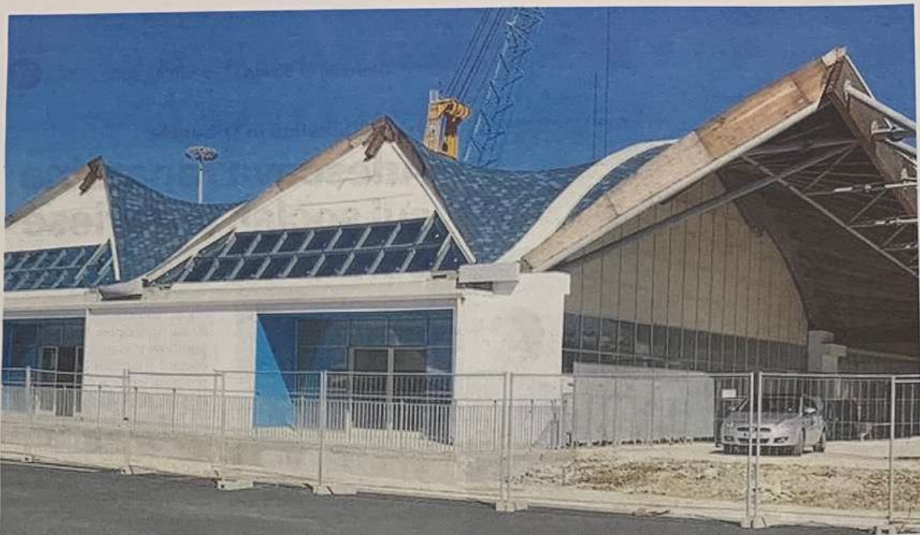
Stazione passeggeri. L'edificio in costruzione a ridosso del punto d'imbarco del catamarano per Malta al porto di Pozzallo
