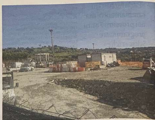
Un cantiere per il raddoppio della Statale 640
