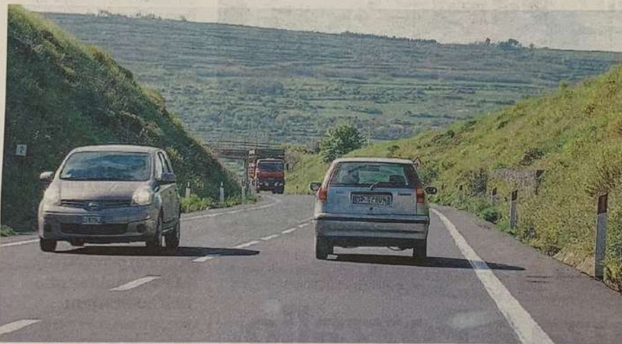
Viabilità. Un tratto della strada che collega Ragusa a Catania, il progetto del raddoppio è ancora bloccato
