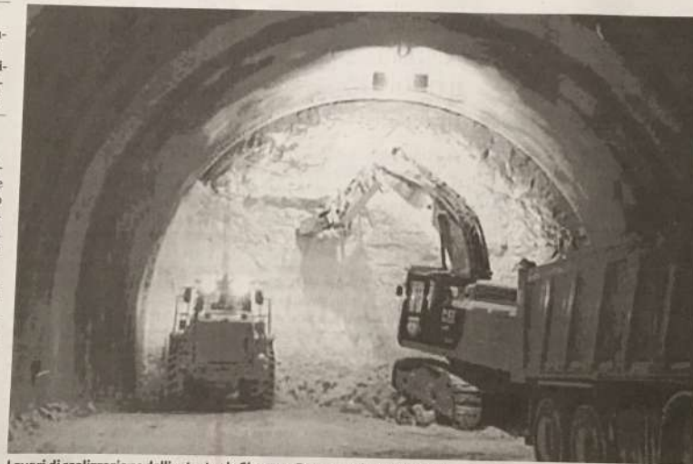
Lavori di realizzazione dell'autostrada Siracusa-Ragusa-Gela. (FOTO ARCHIVIO)
