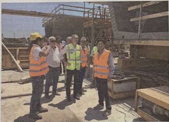
L'assessore Falcone sul cantiere della Siracusa-Gela
