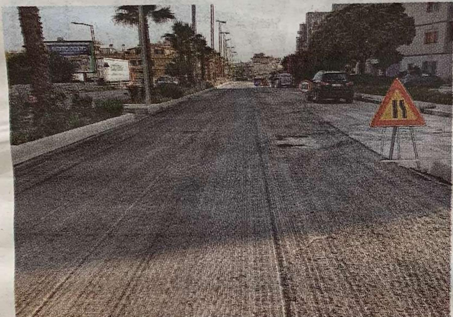
**POZZALLO.** Sono iniziati ieri i lavori di scarificazione per il ripristino del manto stradale della strada provinciale Pozzallo-Ispica e di viale Australia oggetto dell'ampliamento della rete di metanizzazione.
