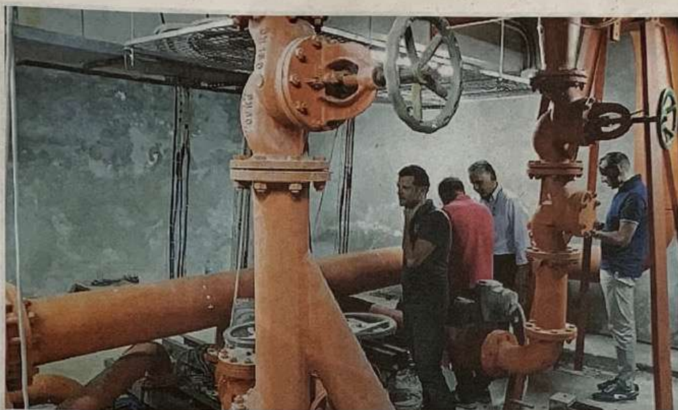
Il controllo | I tecnici durante i controlli alla sorgente Cafeo
