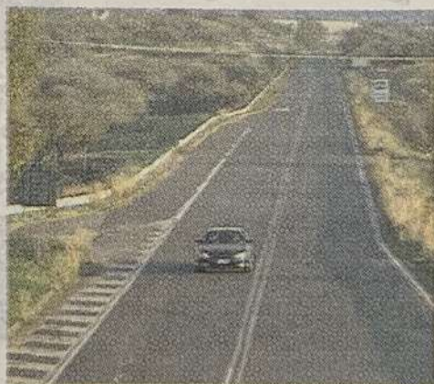
Un tratto della statale 514
