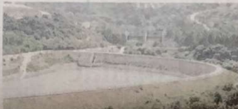
UNA DELLE VASCHE DI IRRIGAZIONE DEL CONSORZIO DI BONIFICA. A DESTRA IL CORFILAC
