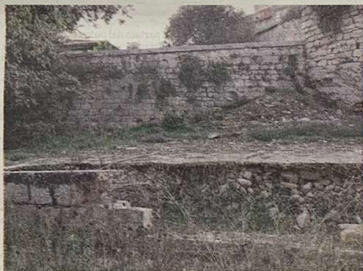
L'alveo di Passo Gatta e, sopra, un momento del sopralluogo
