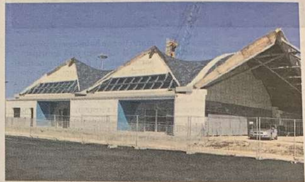
M. F. La stazione dei passeggeri di Pozzallo è in fase di completamento
