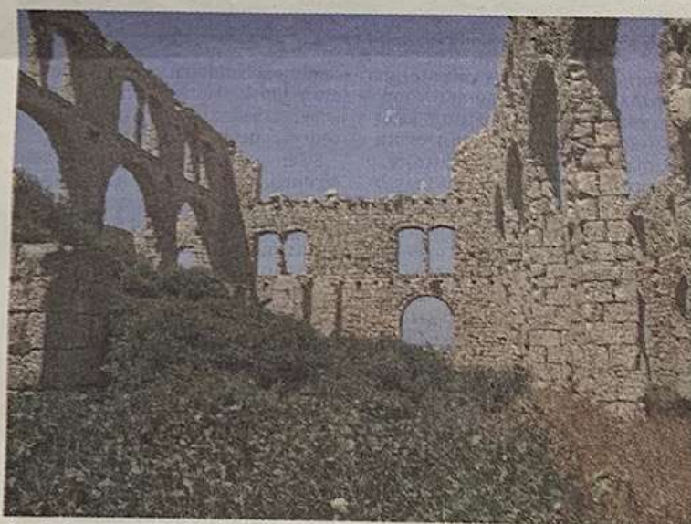
Quel che resta dell'ex fornace del Pisciotto
