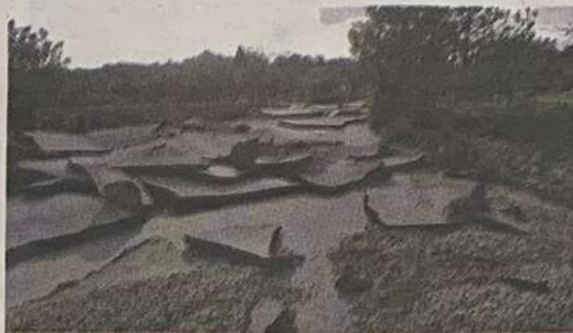
L'asfalto divelto dalla violenza dell'acqua e dalla quantità di pioggia
