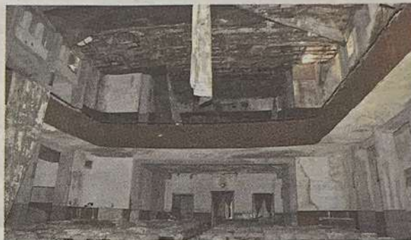
In queste condizioni la struttura venne acquistata dal Comune
